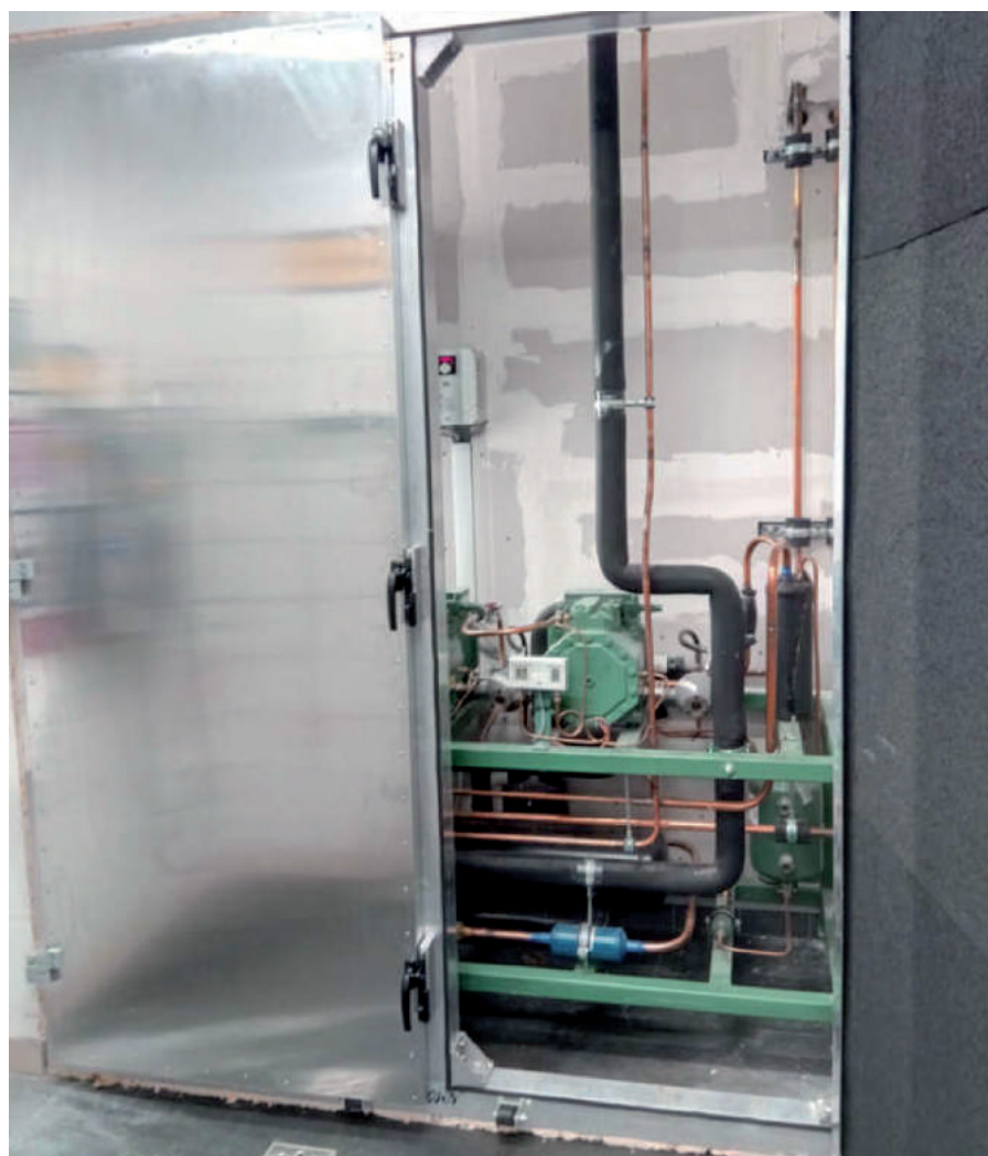
Rys. 2. Komora akustyczna zespołu kompresorów agregatów chłodniczych wysokiej wydajności [opracowanie własne 2020]
