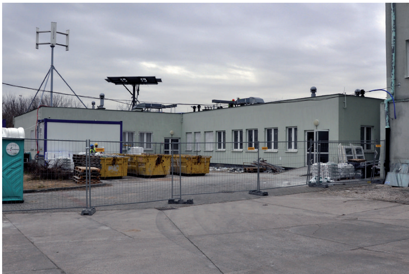
Trwa budowa Collegium Anatomicum
