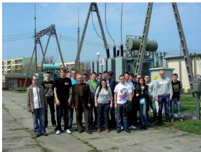
Studenci SKN Elektryk podczas zwiedzania Głównego Punktu Zasilającego GPZ w Radomiu
